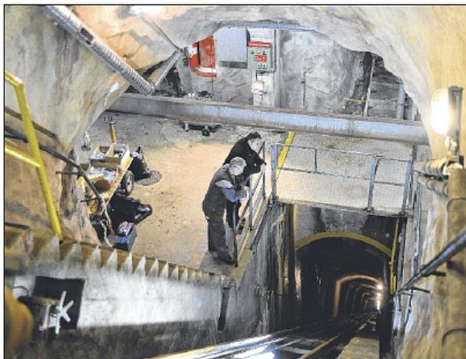
Vertigineux: le funiculaire souterrain reliant les forts de Dailly et Savatan est incliné à 102%.
