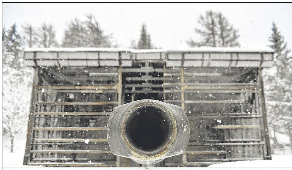
La redoutable tourelle T1 est dissimulée dans une innocente cabane de bûcheron. Le reste du fort est invisible d'ici: tout est caché sous terre!
